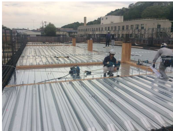
5. デッキ敷・接合具設置 スラブ筋配筋
