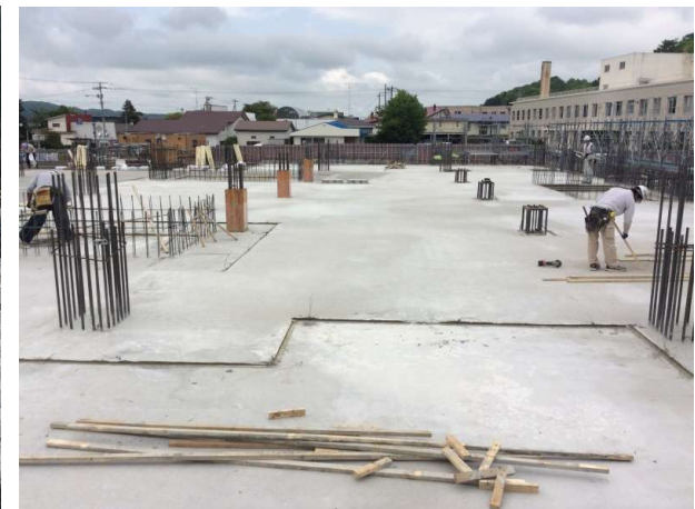
6. 1階立ち上がり コクリート打設終了
