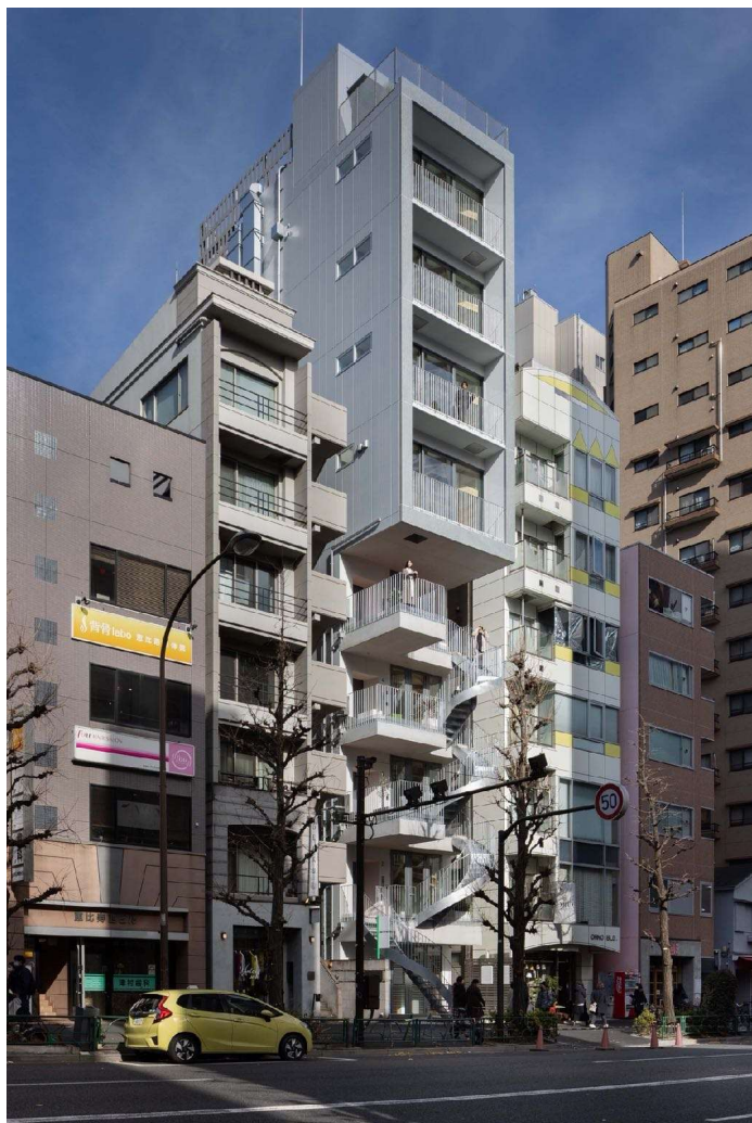
駒沢通り側外観
