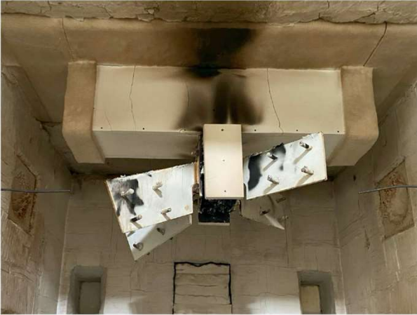
試験体 1 燃焼実験後
