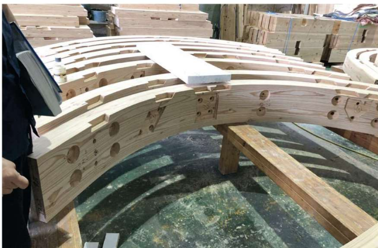
木造部材工場検査（藤寿産業: 福島県郡山市）
