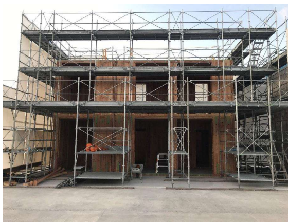
実大試験体施工状況
