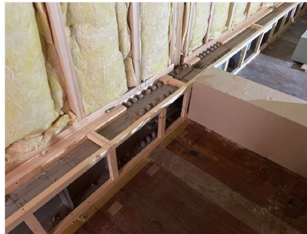
被覆工事中の鉄骨梁の写真
