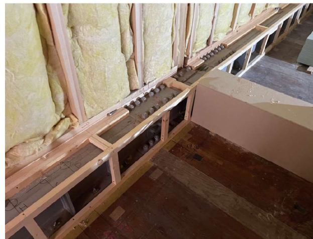
被覆工事の鉄骨梁の写真
