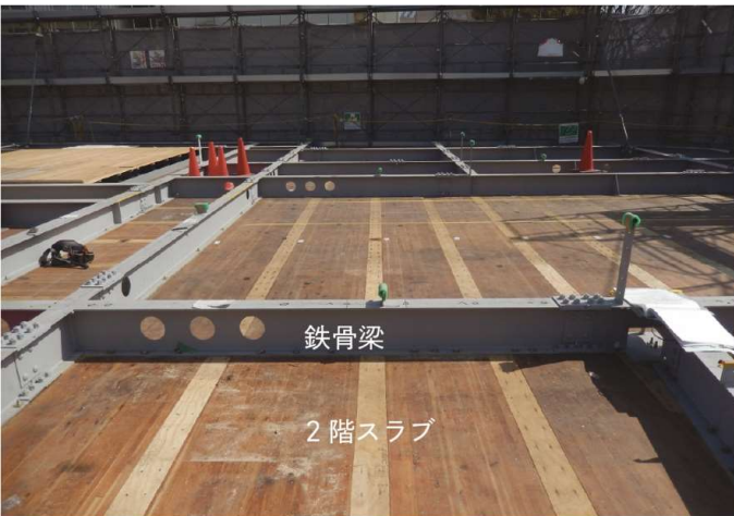
建方工事中の2階スラブ上の写真
