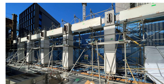
建方状況（遠景）
