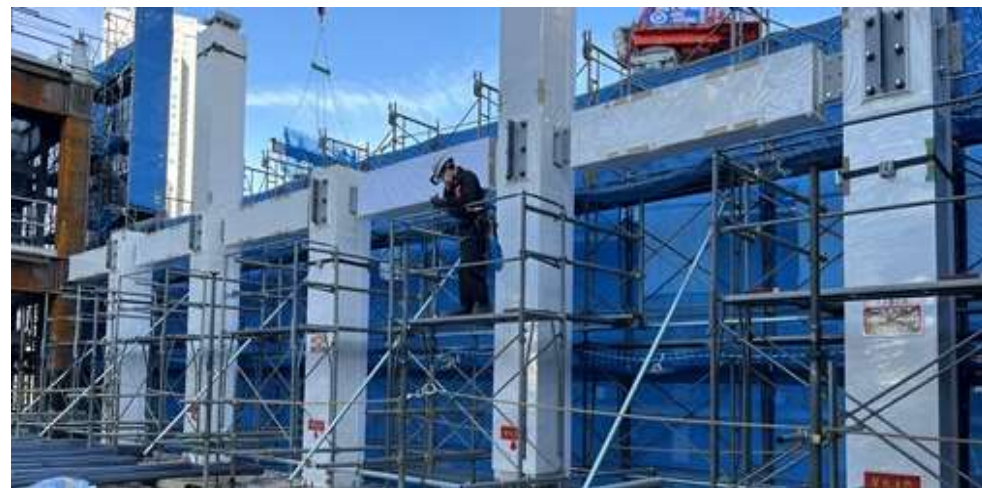
【施工状況写真】
