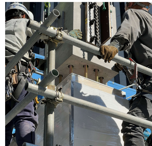
建方状況（近景）
