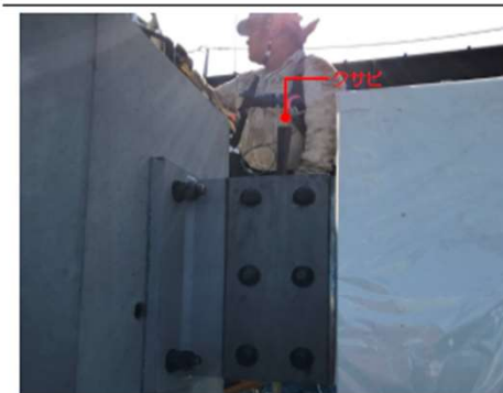
No. 28 検査状況
