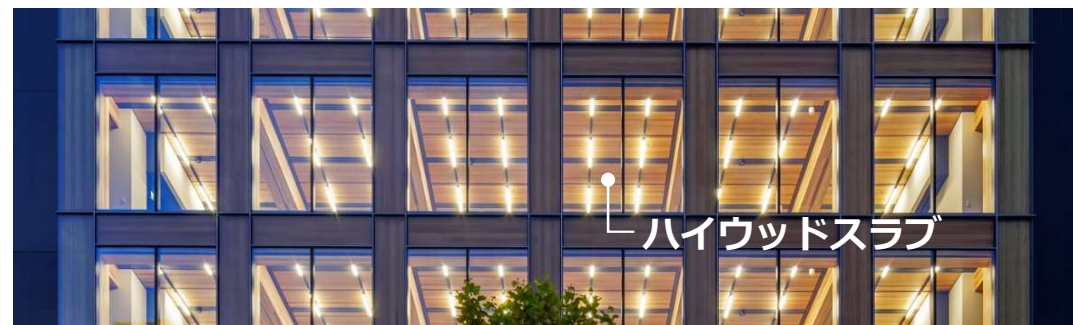
外観見上げ（夜景）
