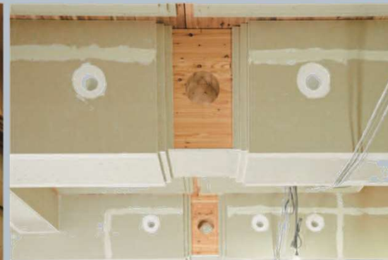
内径 100mm の石膏筒によるスリーブ
