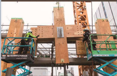
① 十字型ユニット吊り込み
