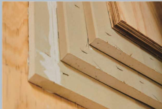
柱・梁の耐火被覆（写真は2時間耐火）
