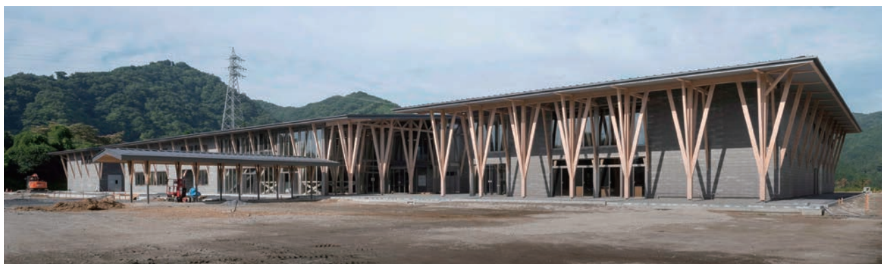
全景 右側に議会ホール棟、左奥に行政棟
