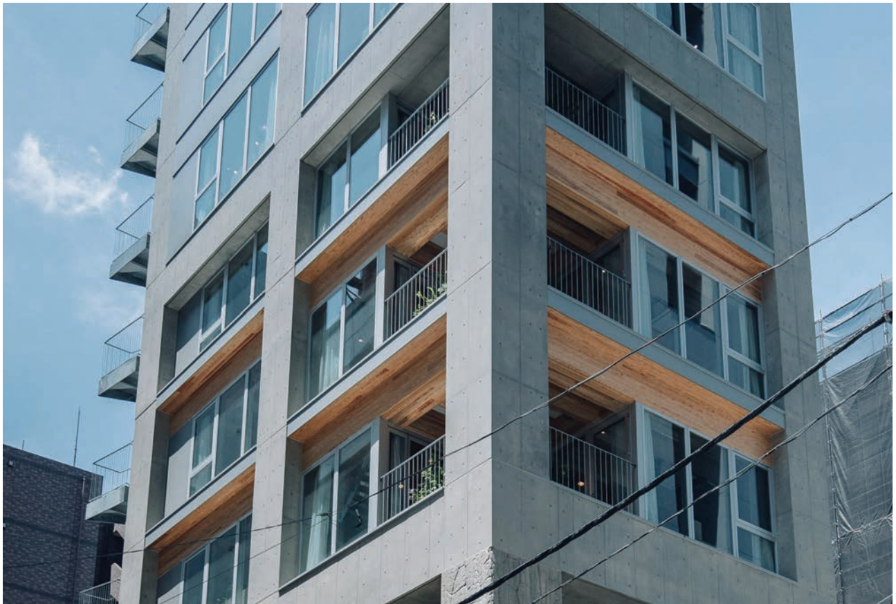
SRCの3層とばしメガストラクチャーに嵌め込まれた木造の階
