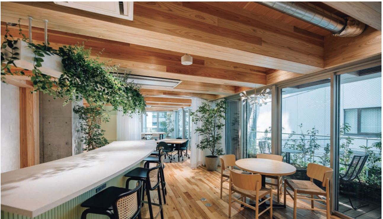
3層飛ばしのSRCメガストラクチャーに嵌め込まれた木造の階の内観
