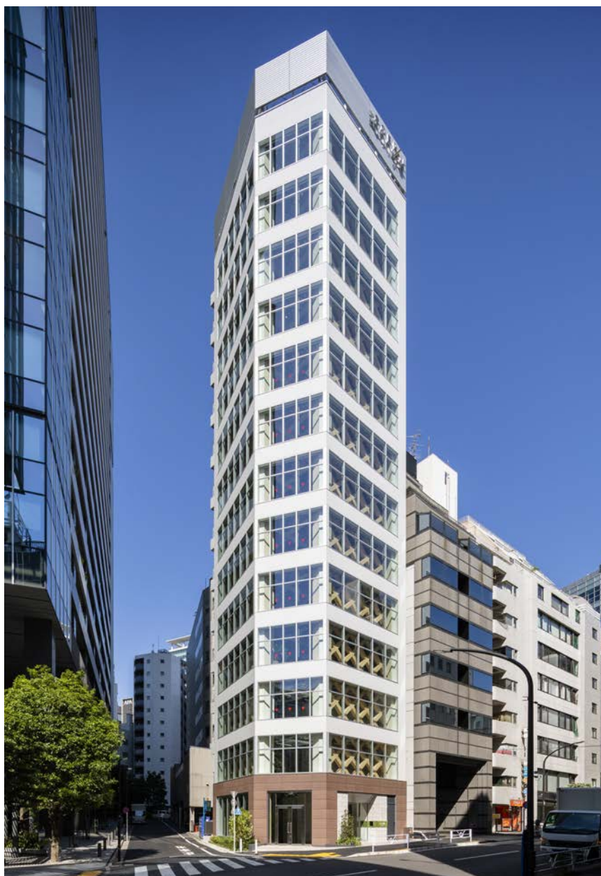
東側から見る外観
