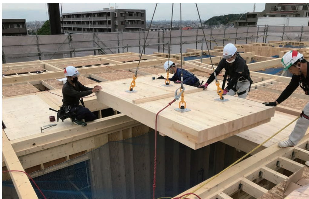
NLTの施工風景
