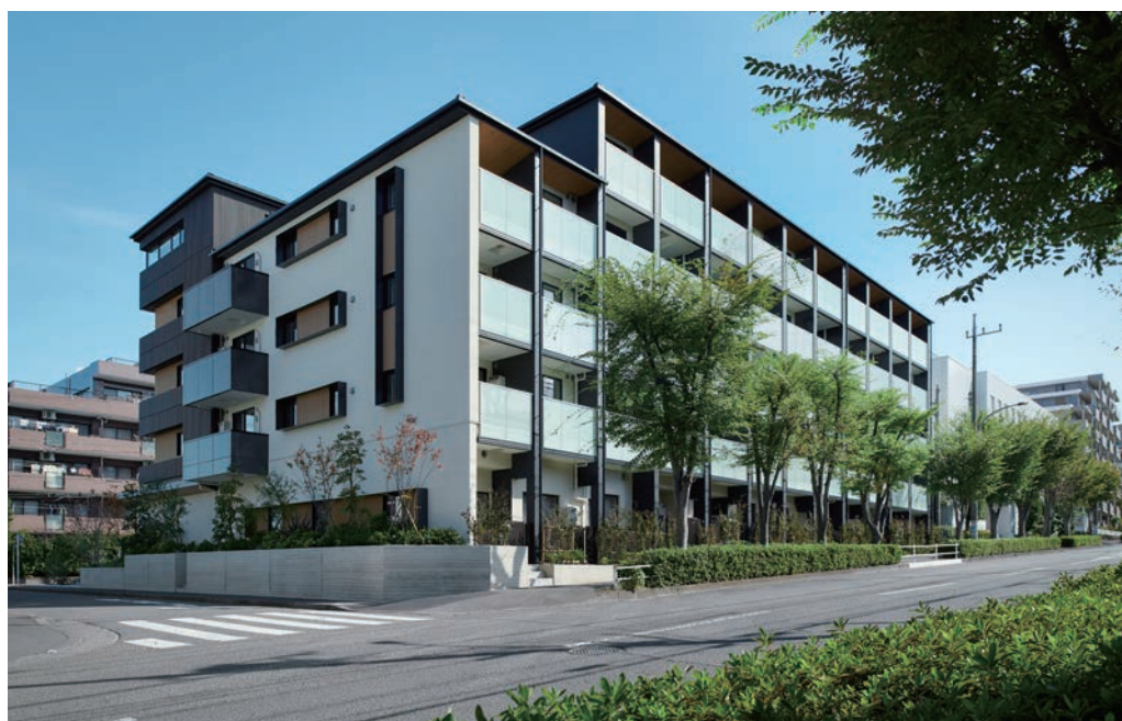
南西側から見る外観
