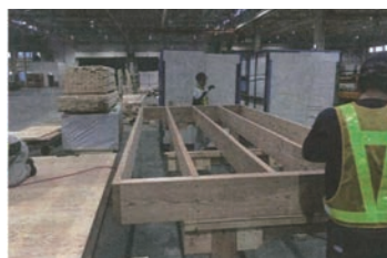
床パネルの試験生産の様子
