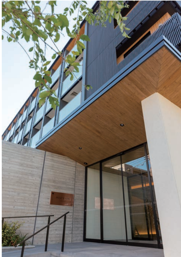
エントランス部の外観
