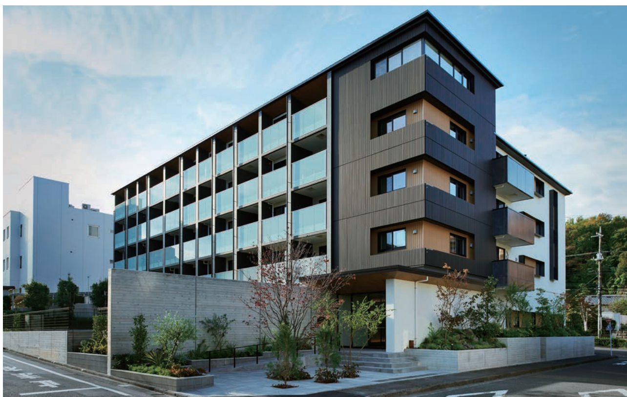
北西側から見る外観
