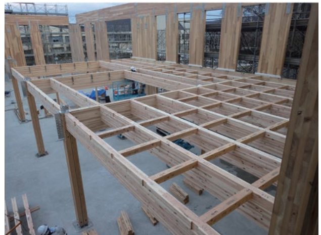
中断面集成材の軸組工法による内部施工の様子
