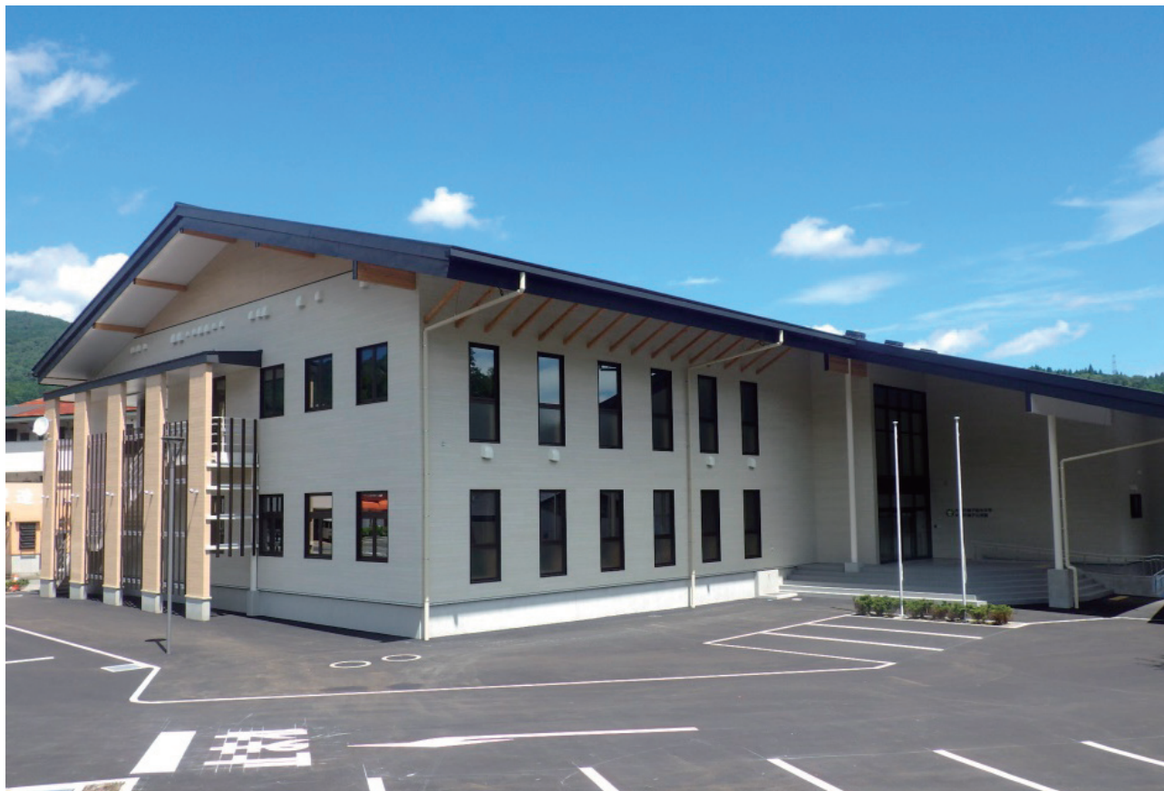
南西側からの外観
