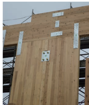
鋼板添え板ドリフトピン接合金物
