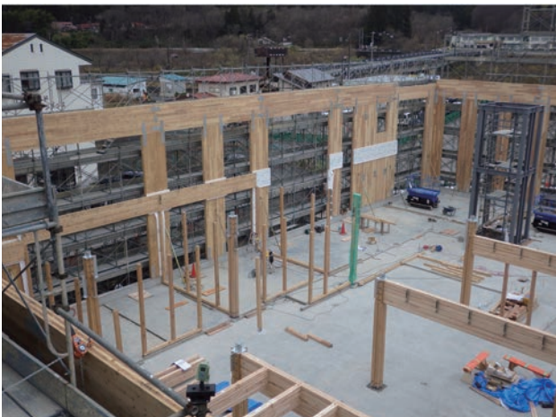
外周部2層通しCLTパネル壁施工の様子
