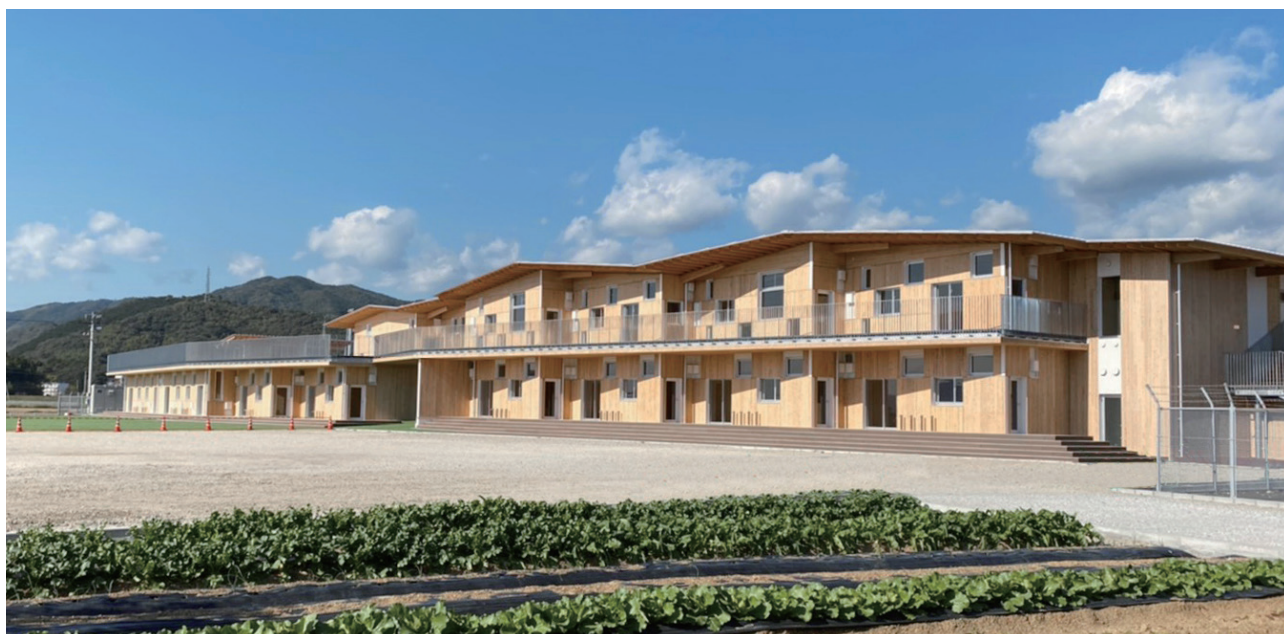
南側からの外観
