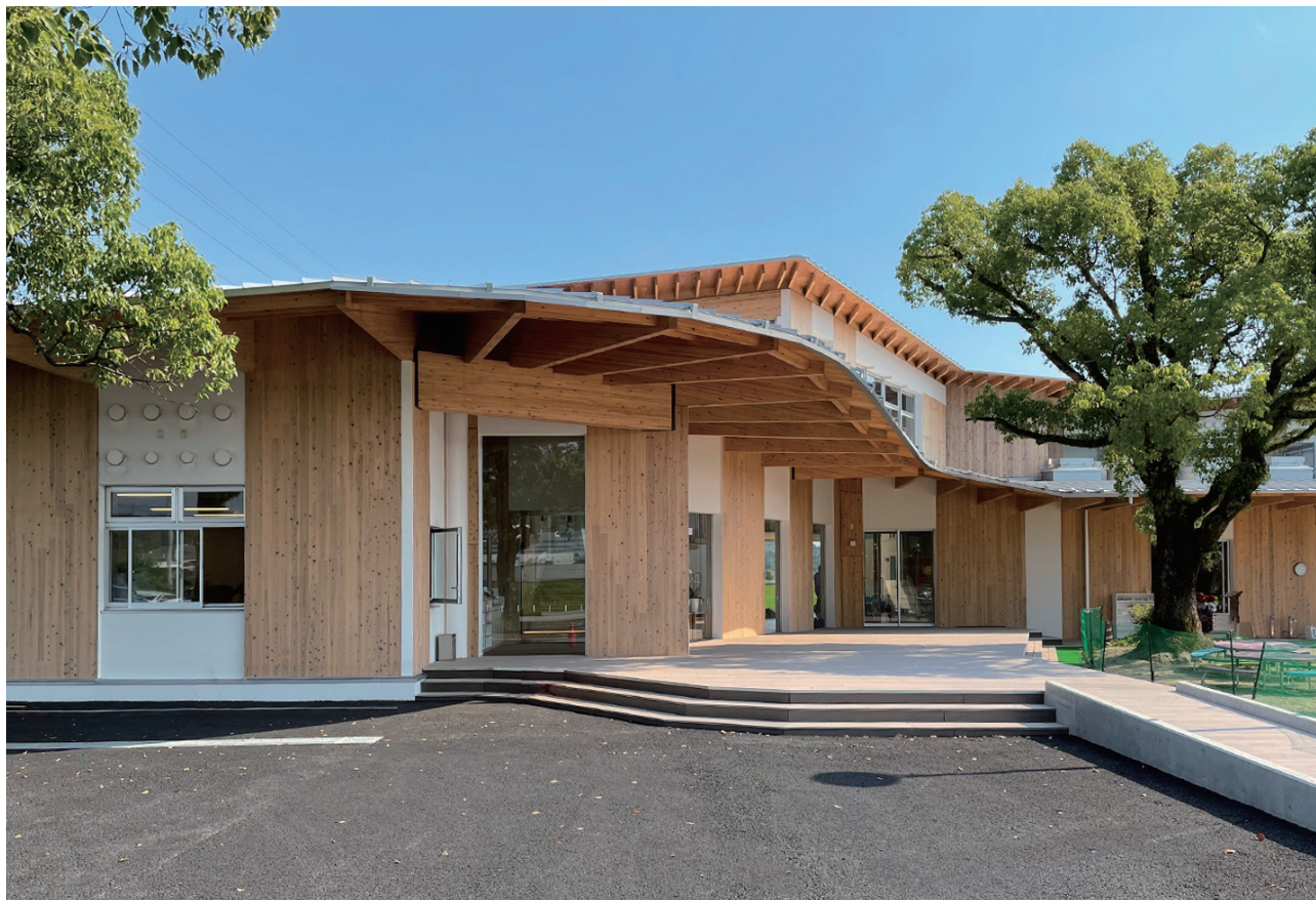
北側、玄関まわりの外観
