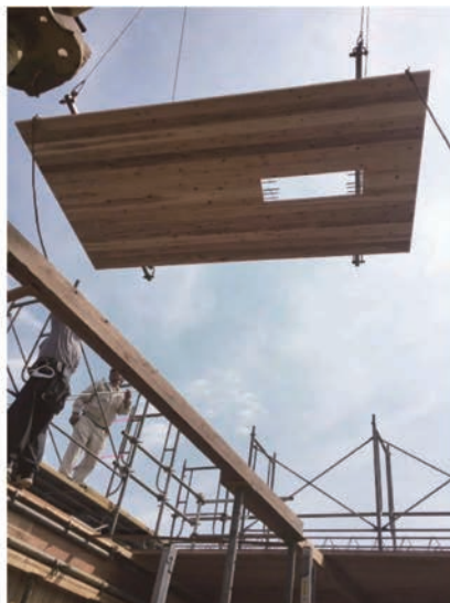
配筋付き製材型枠を用いた施工風景
