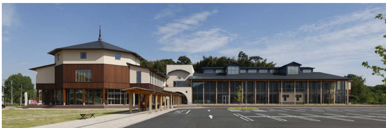
南からの全景 左に議会議棟、右に執務棟
