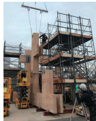
実大施工試験の様子
