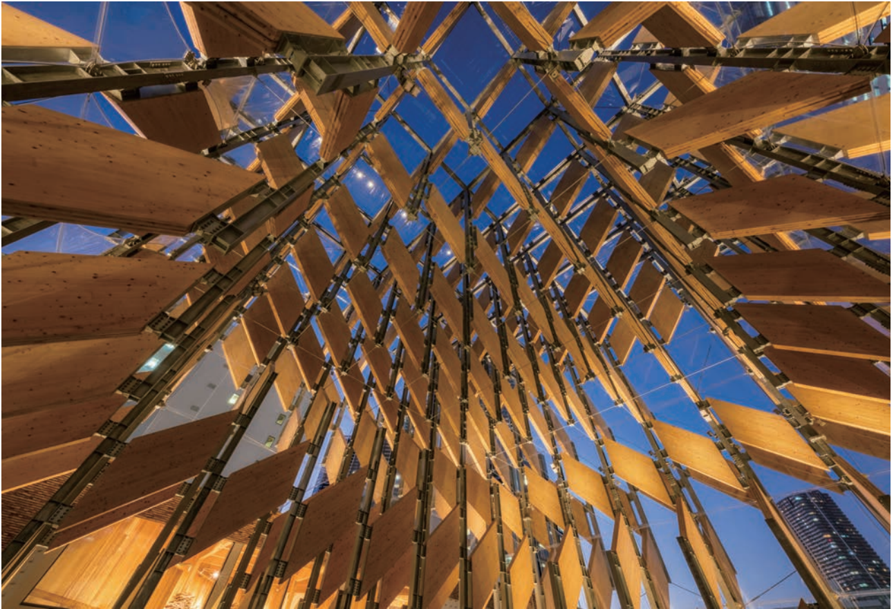
パビリオン棟の内部からの見上げ 連続した CLT パネルで梁を構成
