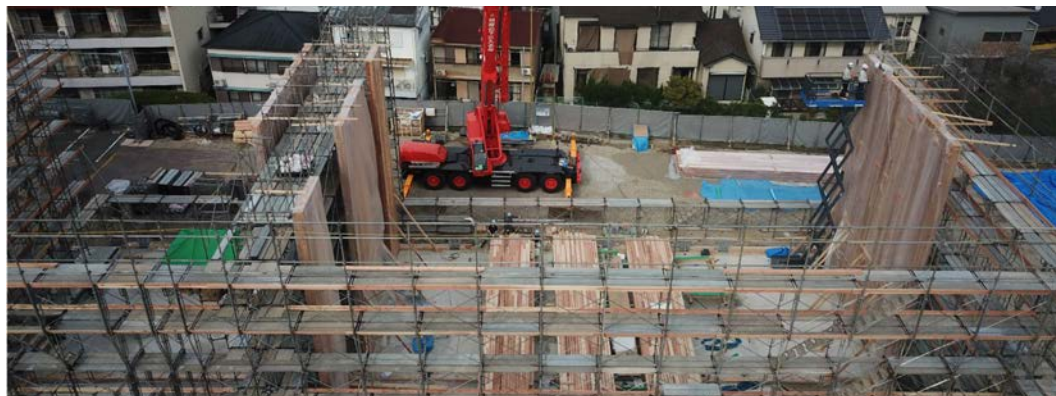
CLT パネルの施工の様子
