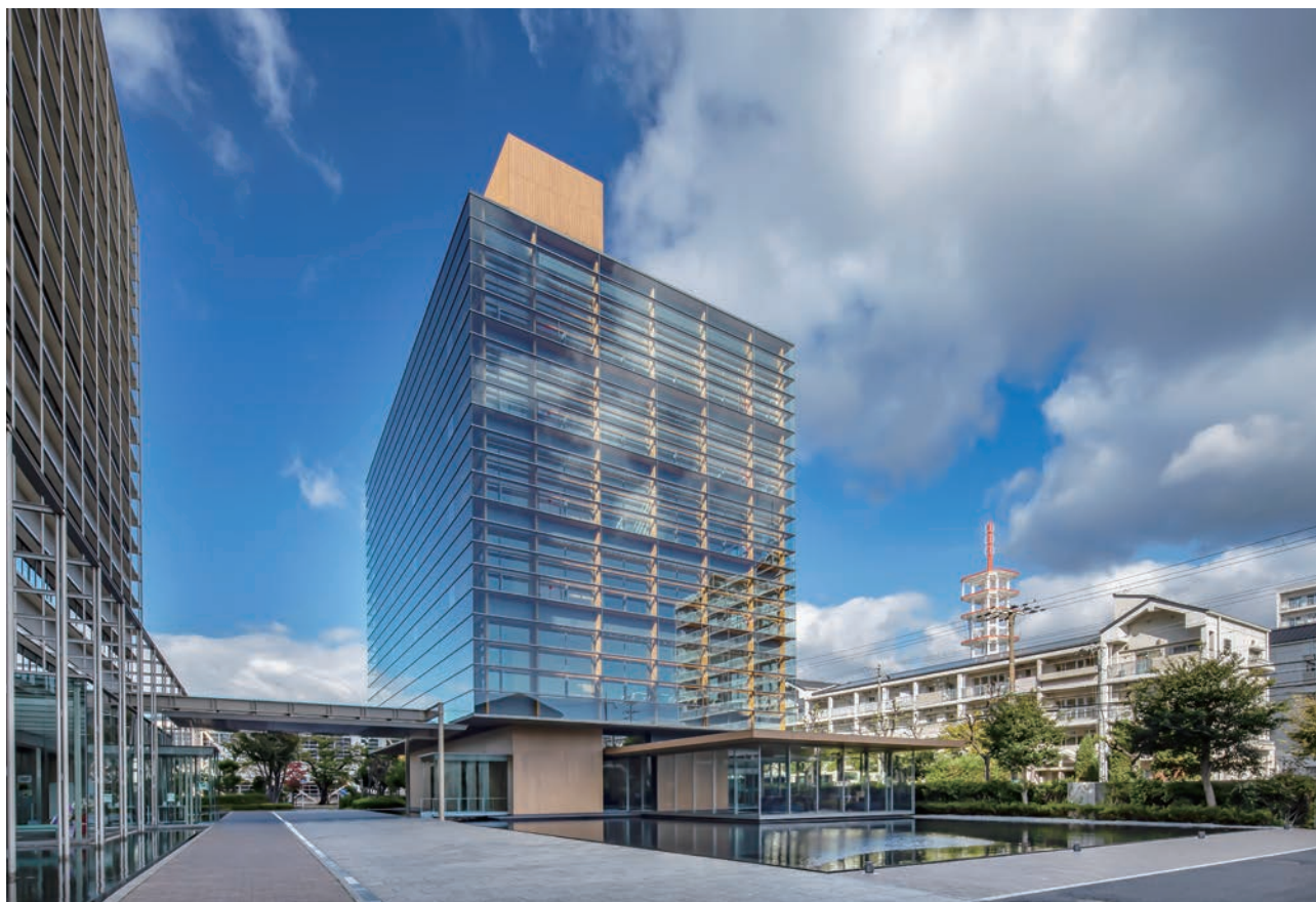
東からの外観 (左は既存本社棟)
