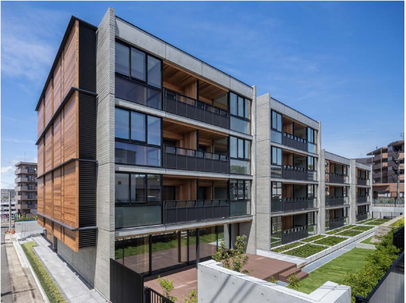
南側からの全景
