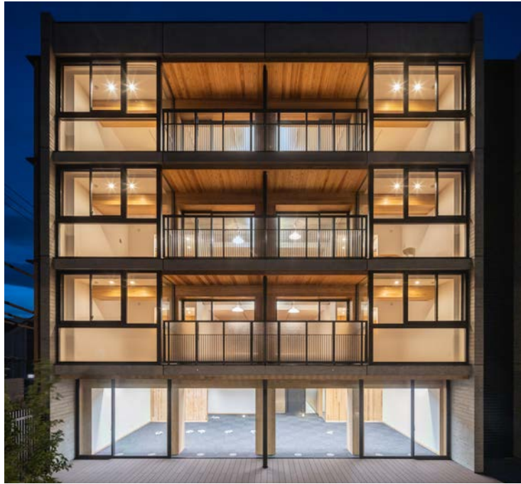
南側からの夜景 1階にテレワークルーム
