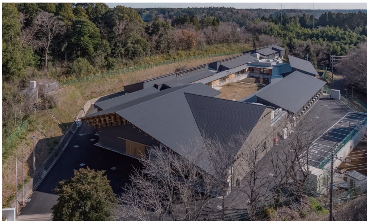
北西側からの全景俯瞰写真
