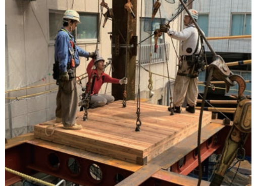
現場での CLT 版の吊り込みの様子
