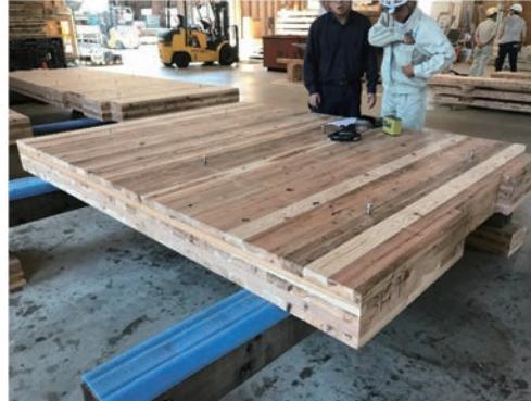
CLT 版の工場での製作
