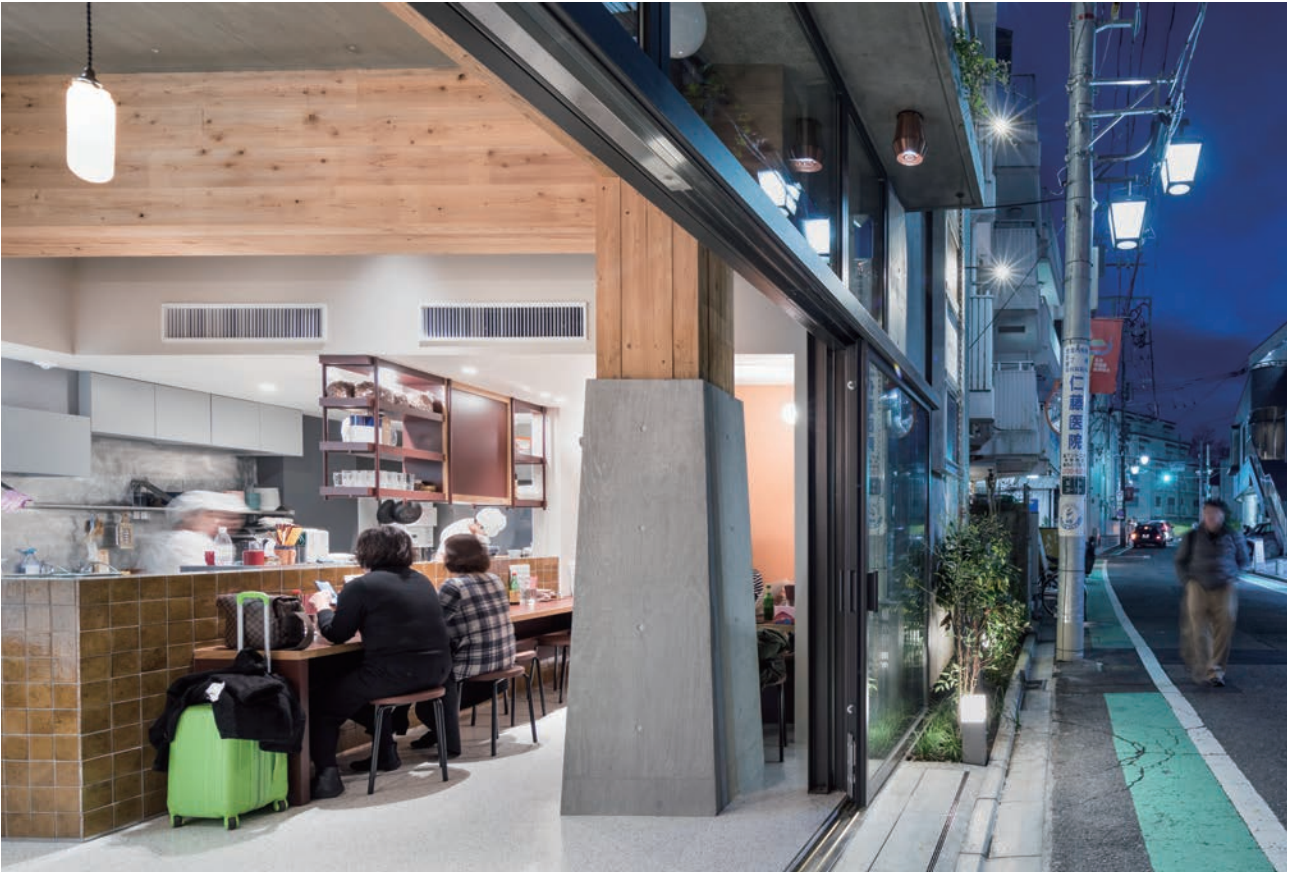
街路より1階店内を見る 木造東ね柱・重ね梁のフレームがよくわかる
