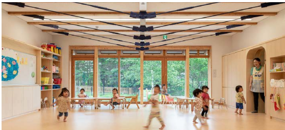
張弦梁架構の保育室
