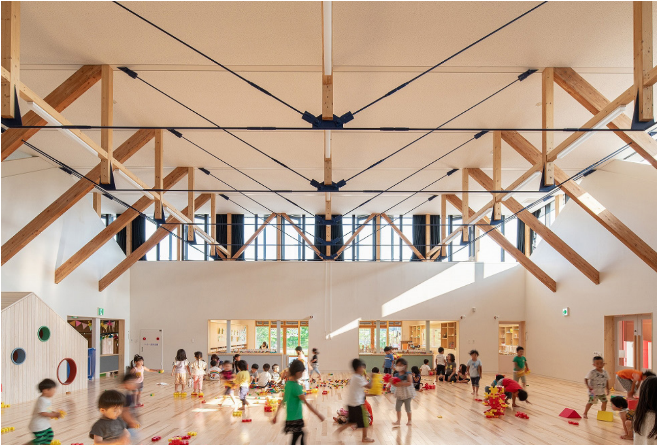
3ヒンジ方杖+張弦梁構造の遊戯室
