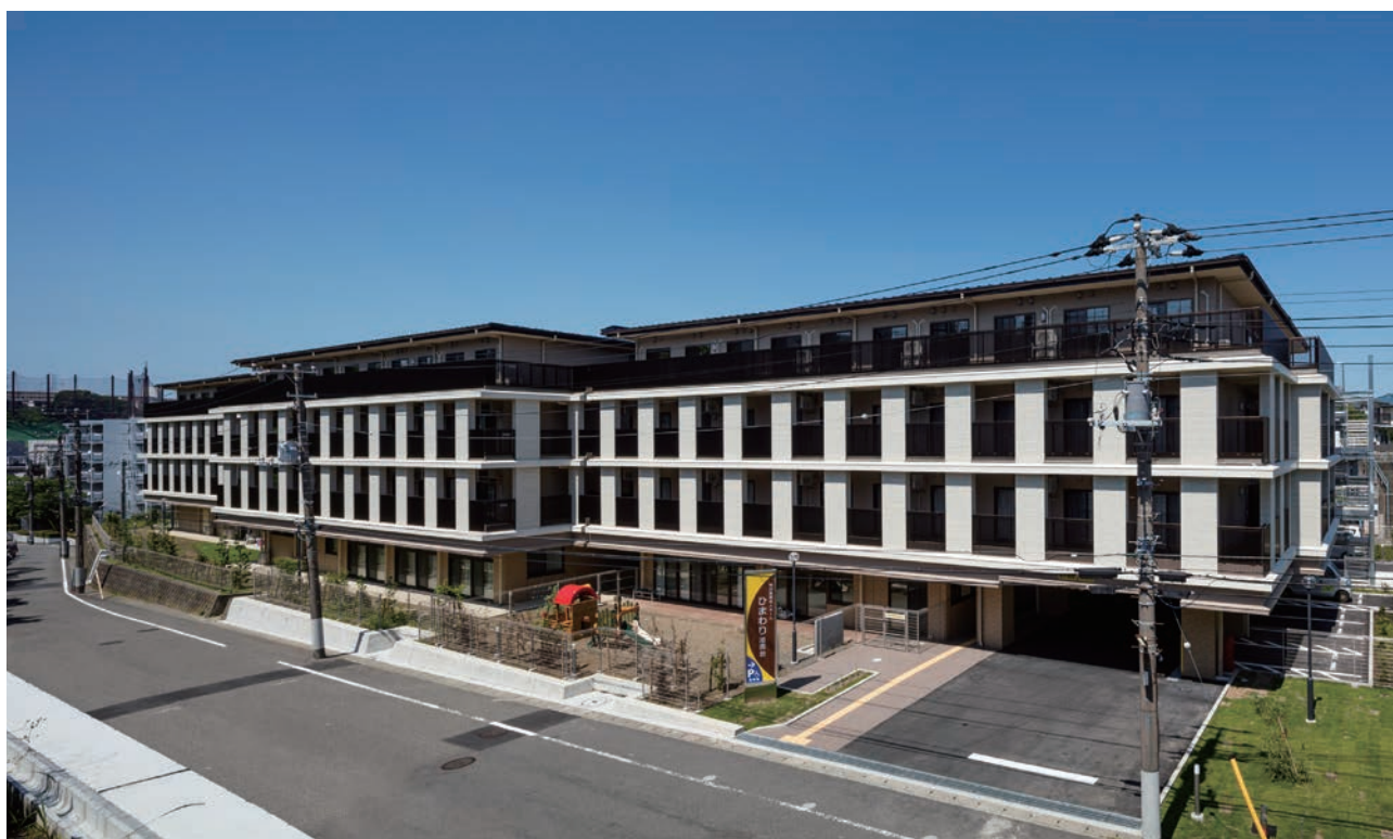
南側からの全景
