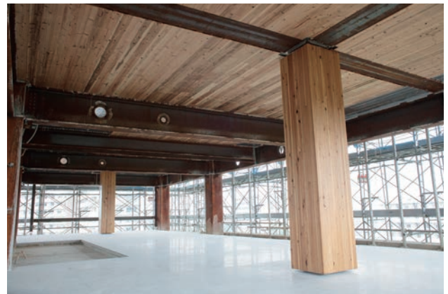
コンクリート施工完了
