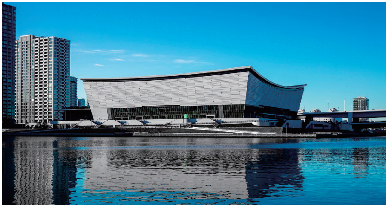
北東側から見るアリーナ全景
