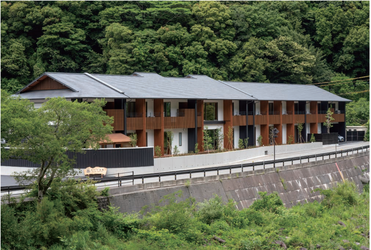
南側からの全景
