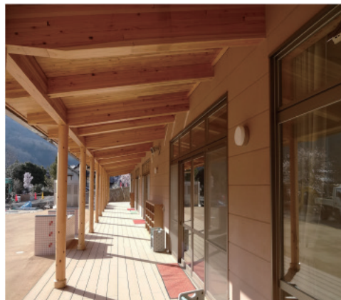
園庭に面したテラス
