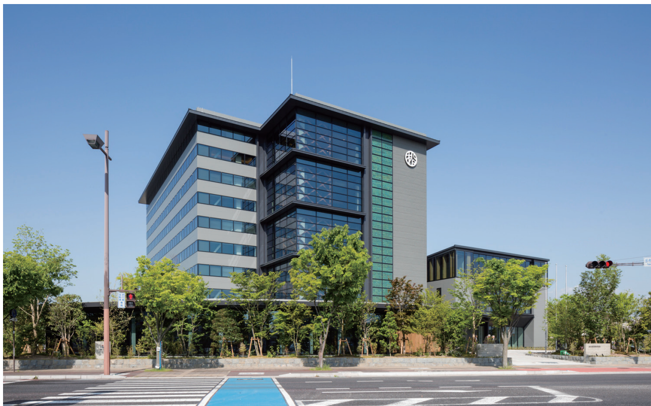
東南面外観 正面に 5 階建事務所棟、右に低層の会議室棟
