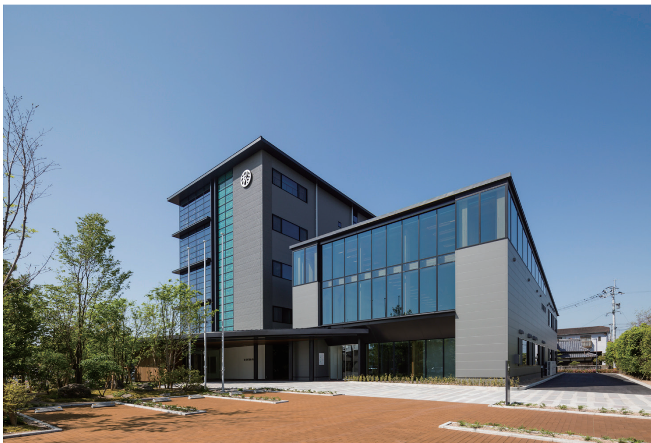
北東面外観 左：事務所棟、右：会議室棟
