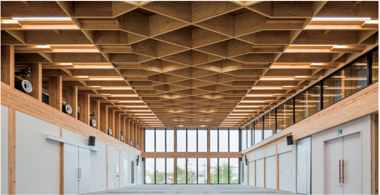
大会議室 ゲルバー桁橋の屋根架構
