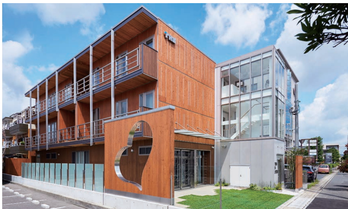
東側から見た外観
