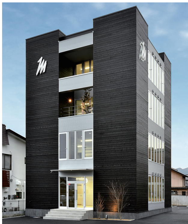
北東面外観全景
