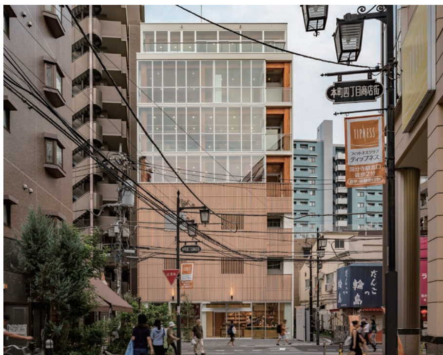
北側から見る外観
