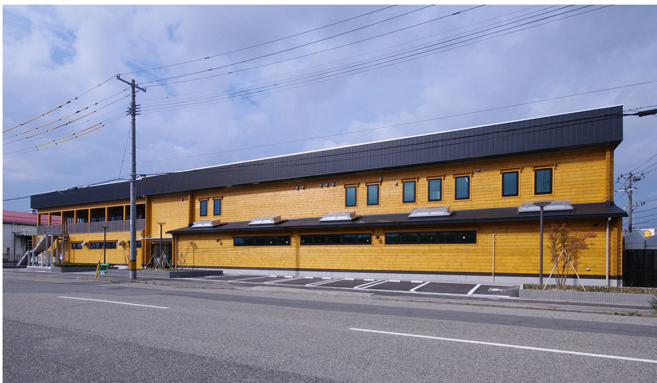
東側から見る外観
