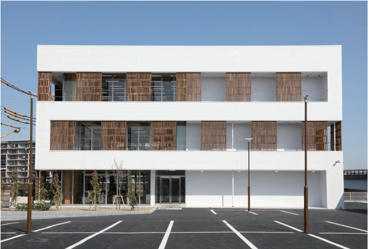
事務所棟の北側外観
