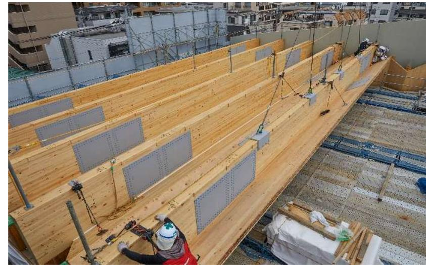
折板構造の梁は、現場で鋼板を添え板とし接合し、**17メートルの大スパン**を飛ばす。
