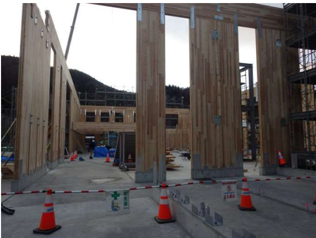
① 外壁面CLTパネル
