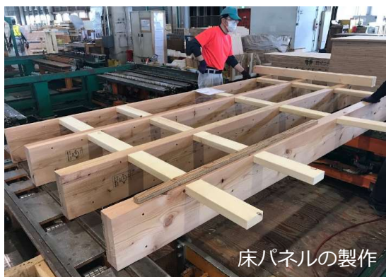
床パネルの製作
