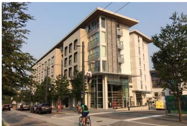
カナダ BC州 2017年 6階建 集合住宅（木造） 延床面積：約7,317㎡ パネル施工
