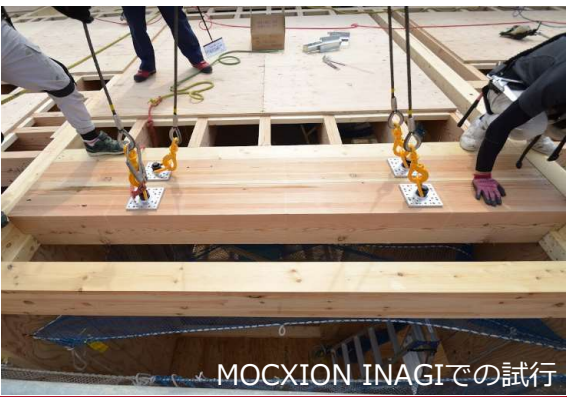
小断面材を釘接合する
