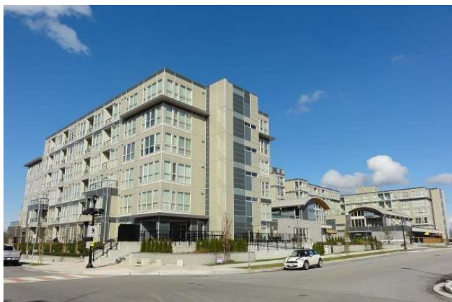
カナダ BC州 2012年 6階建 集合住宅（木造） 延床面積：約18,215㎡ パネル施工
