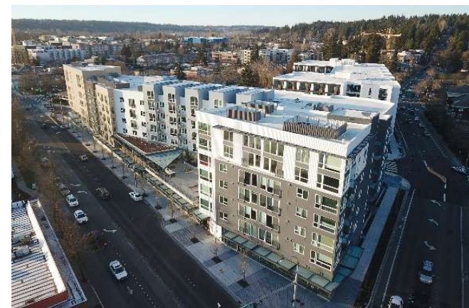
アメリカ ワシントン州 2018年 7階建 集合住宅（1階RC造） 延床面積：約15,900㎡ パネル供給
