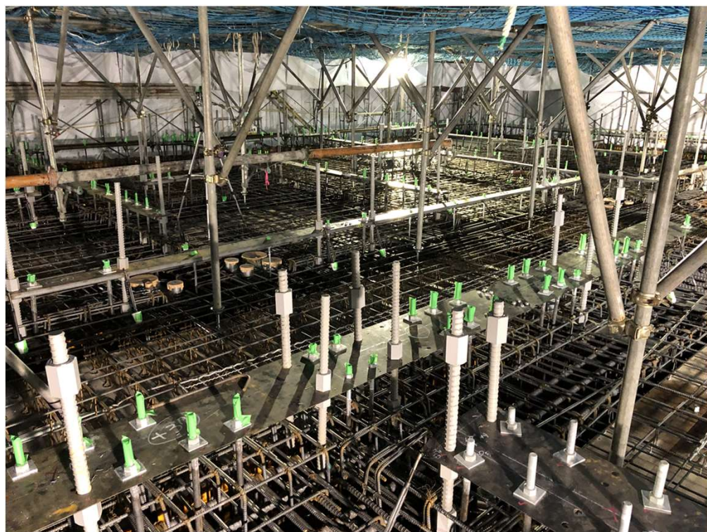
9階 タイダウン、アンカーボルト設置
