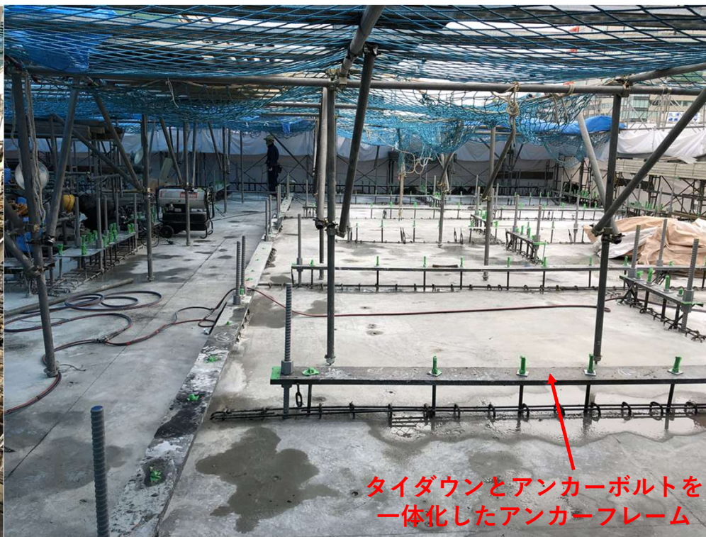
9階 RC躯体打設後
