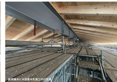
既存棟木に木造垂木を施工中の写真
