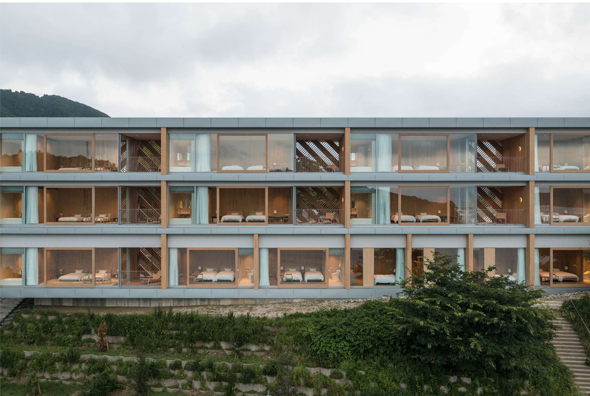
(海側の外観) 3層のCLTパネル構法 海沿いに客室がならぶ。
