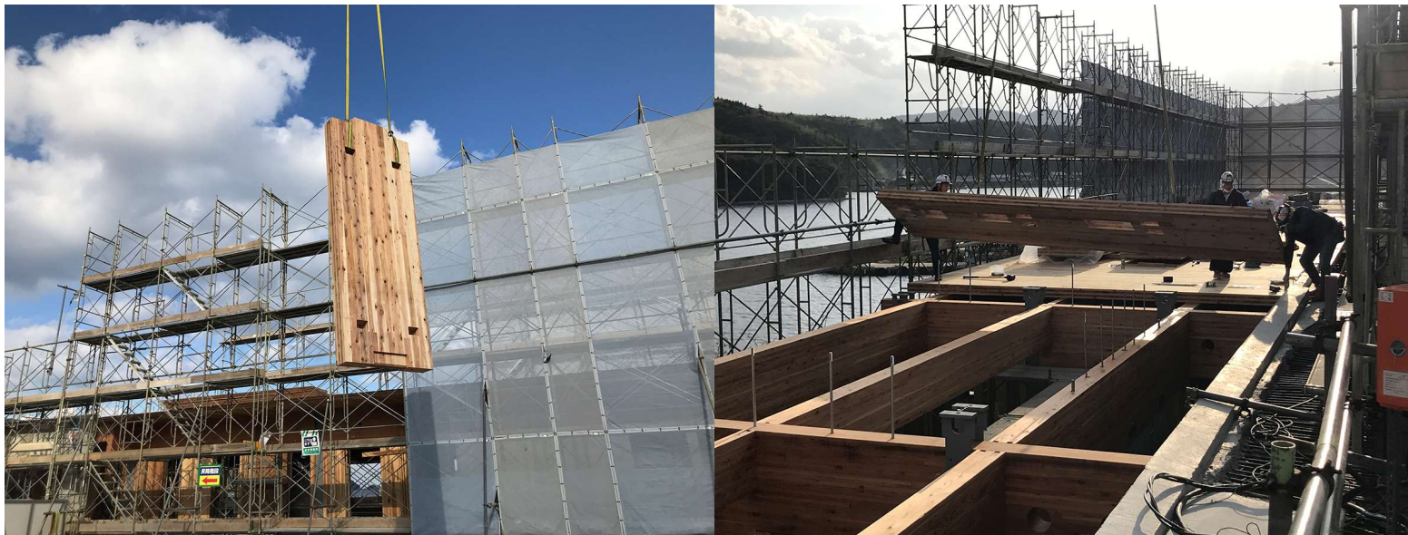
左：クレーンによりパネルを吊り運ぶ 右：スラブ設置の様子
