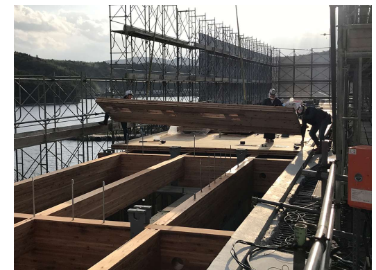
集成材合成梁の上に床パネルを設置してる様子
