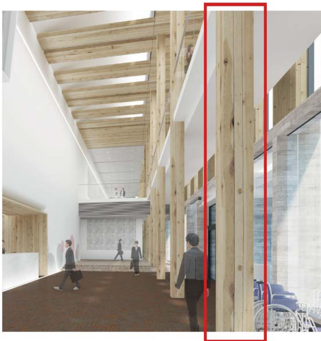
スギ材による鉄骨柱の防火被覆
