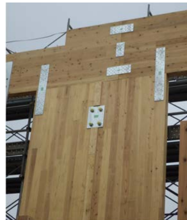
鋼板添え板ドリフトピン接合金物
