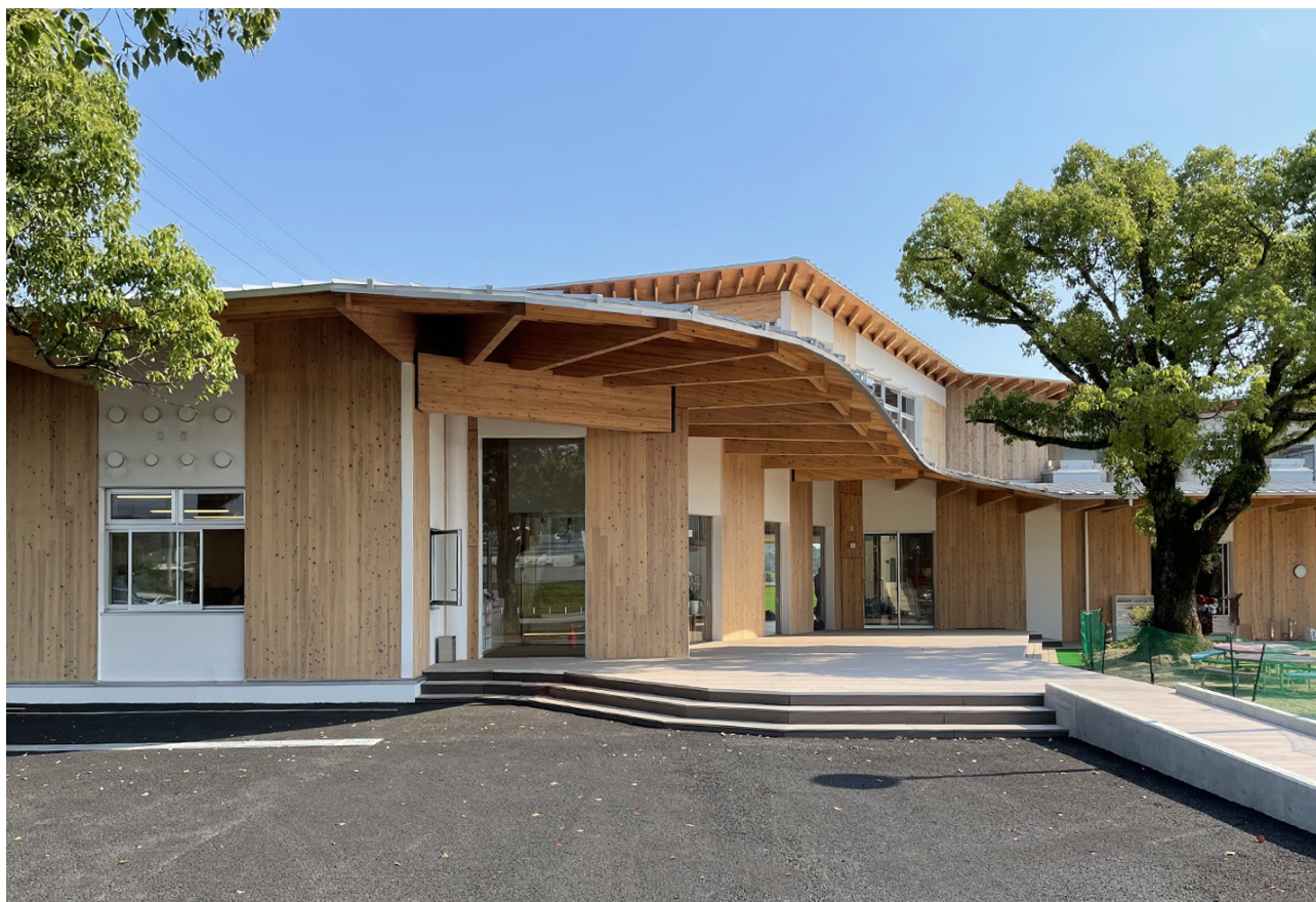
北側、玄関まわりの外観
