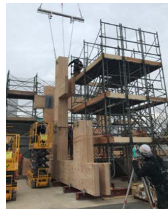
実大施工試験の様子
