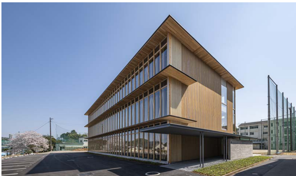
ガラスを通して木の構造体を見せる外観
