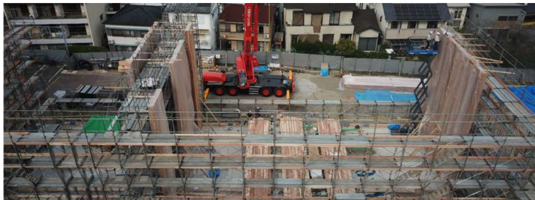
CLT パネルの施工の様子
