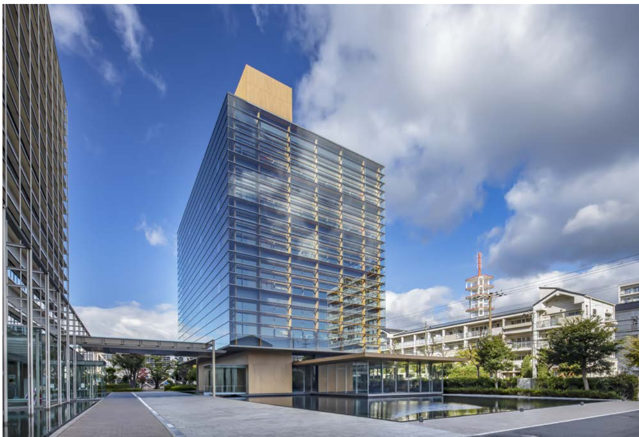
東からの外観(左は既存本社棟)
