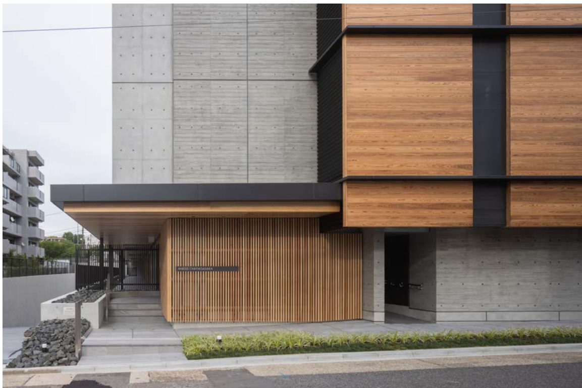
木の外装が迎えるエントランス
