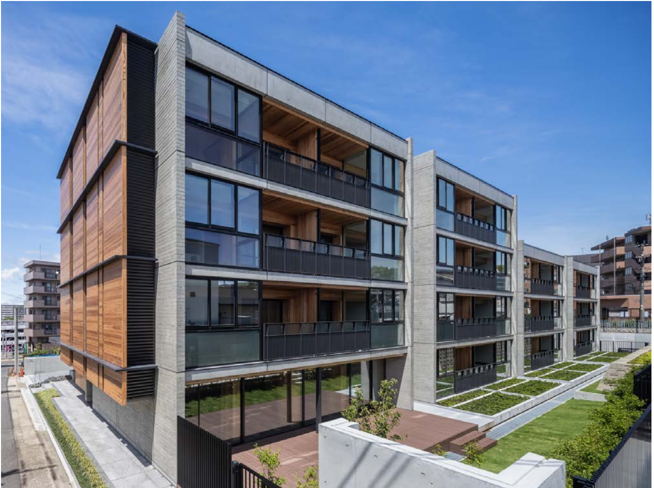
南側からの全景
