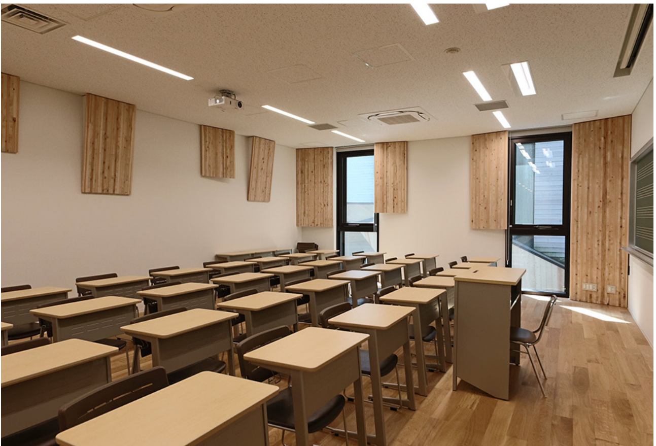
CLT の端材を利用した教室の内観
