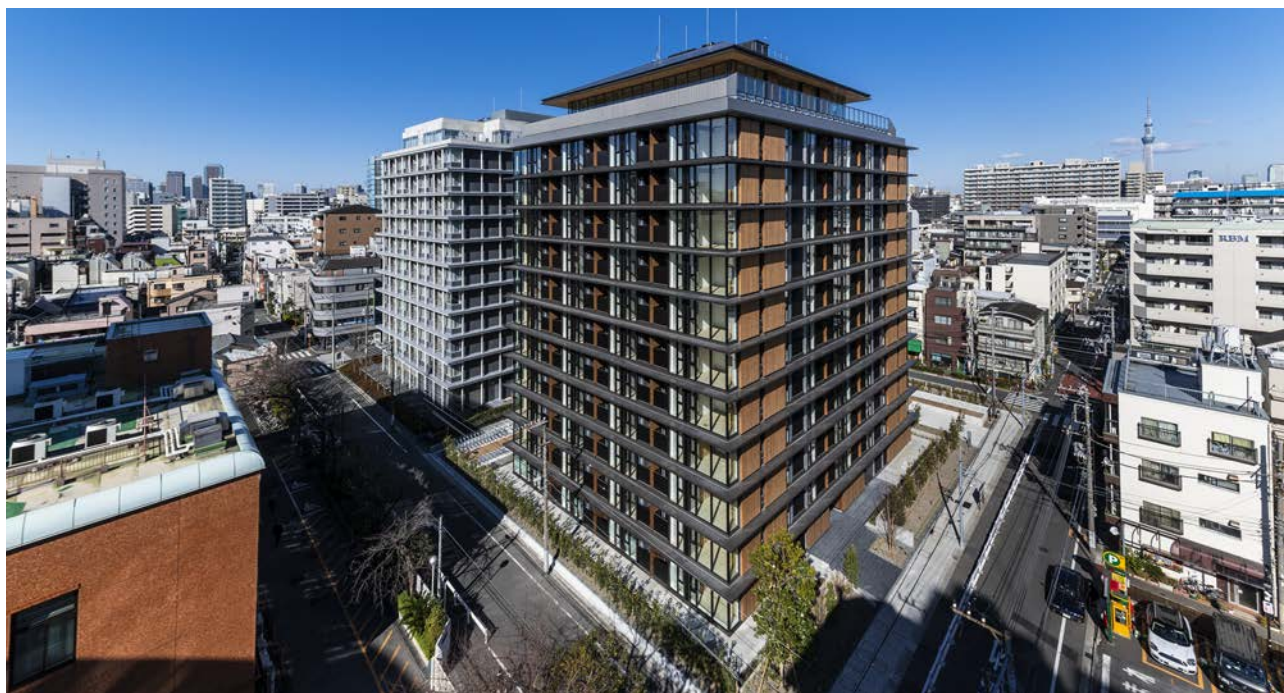
東南側から見る外観 後方の RC + S 造の棟と並んで建つ RC + W 造の建物
