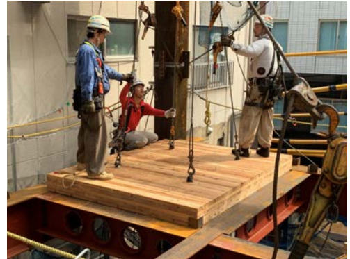
現場での CLT 版の吊り込みの様子
